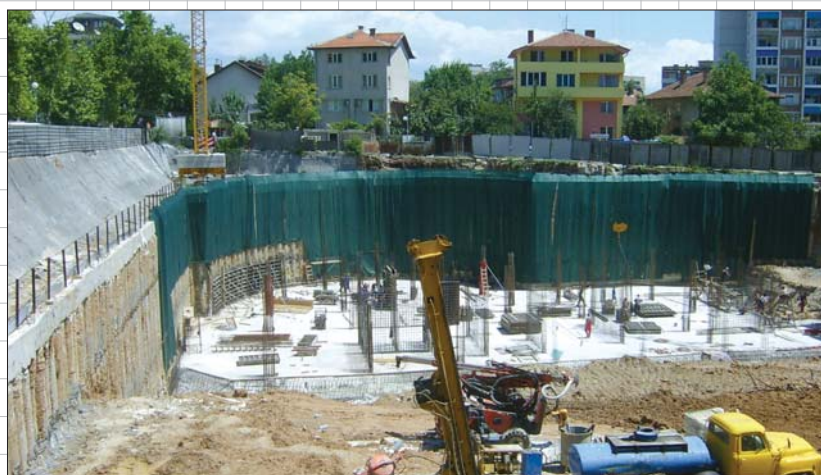
Укрепване на строителен изкоп с пилоти и анкери
