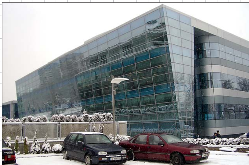
Проектът "East Park Business Center" спечели първо място на конкурса "Сграда на годината за 2005" в категорията "Офис сгради"
