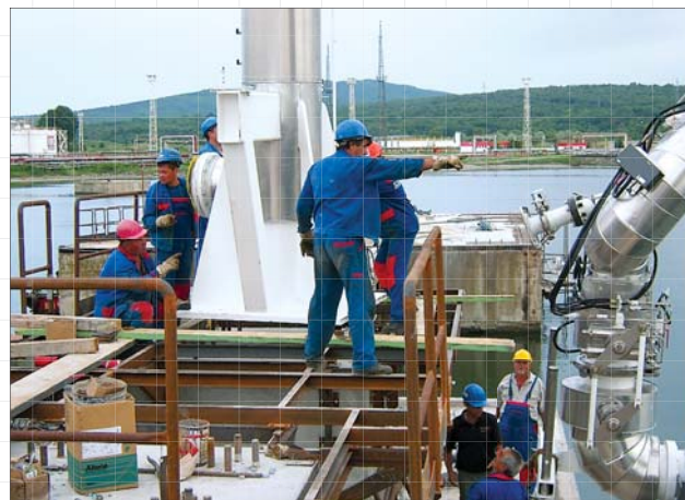
Изпълнение на укрепителни съоръжения по проект на фирмата
